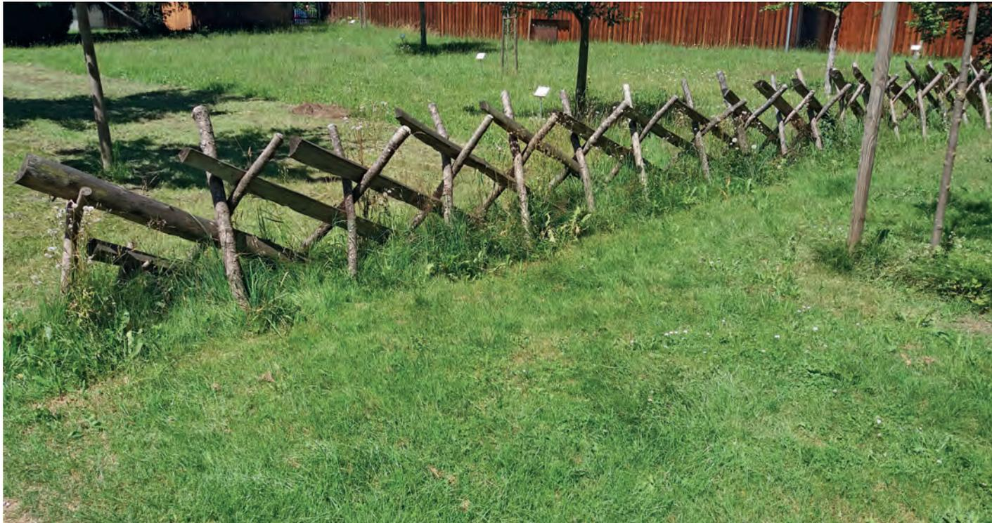
*Schrägzäune bestehen aus den Stecken (Stotzen, Stötzli), welche das Kreuz bilden und den Einlagen (Scheien, Latten). Die Stecken sind etwa mannshohe aufgespaltene Stäbe, etwas dicker als Rebstecken.*
